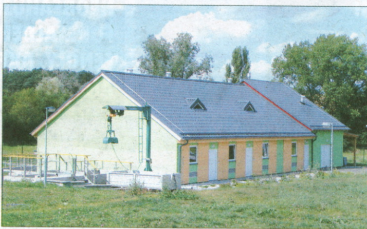
Budova ČOV postavená ze systému Flexibuild.
